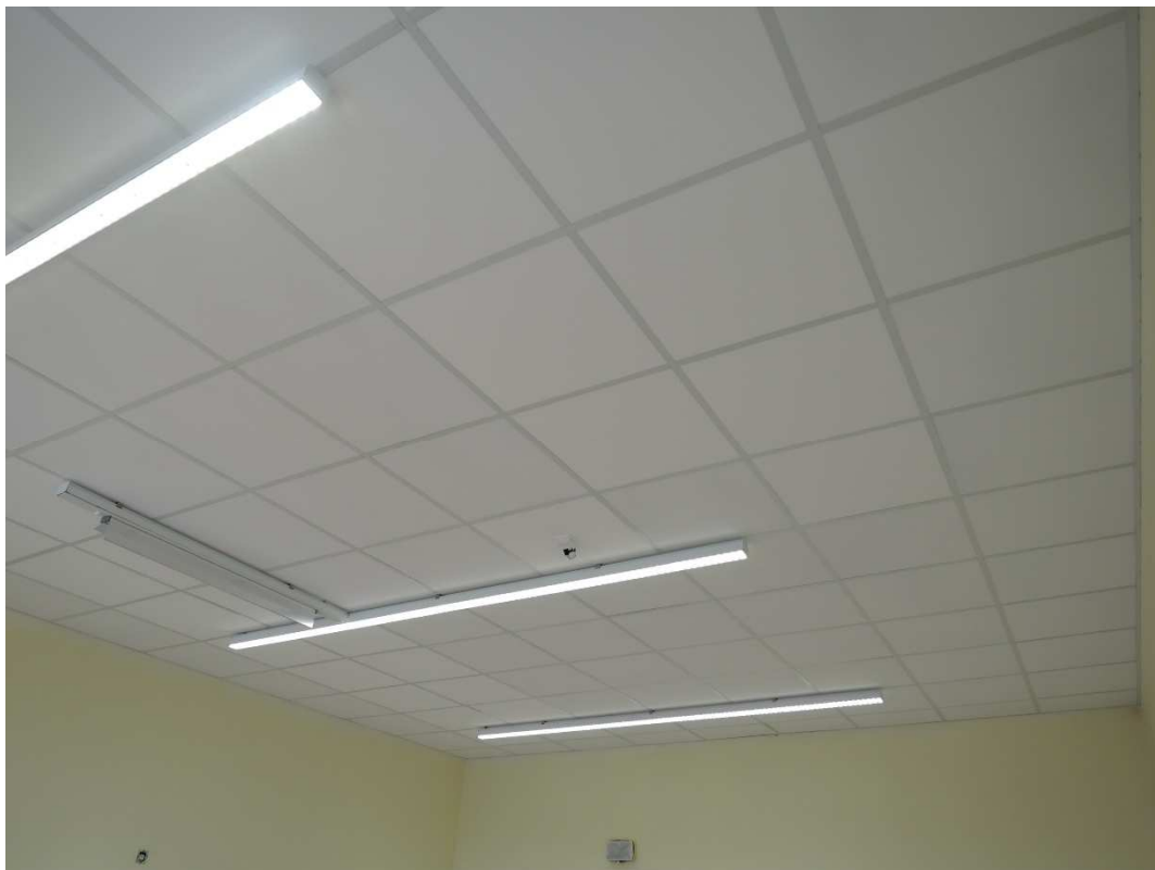
Obr. 5 – ukázka z realizace rastrového podhledu.
